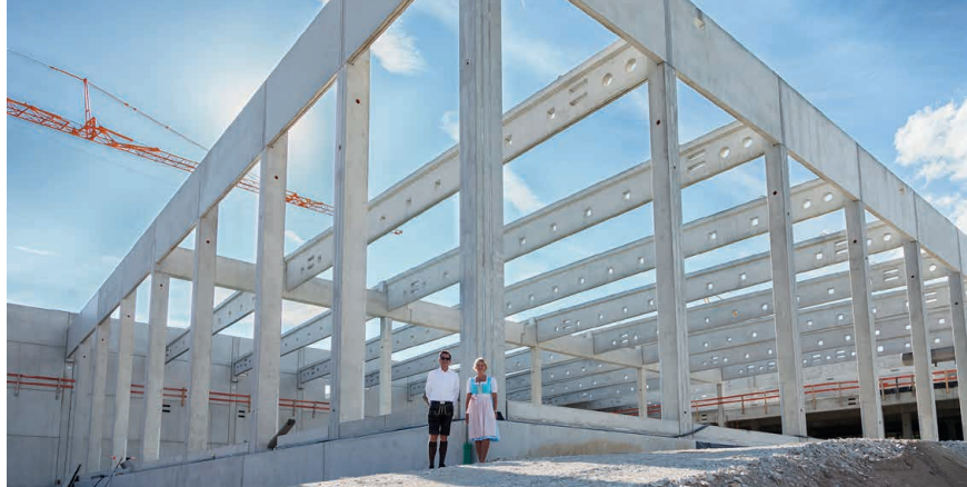
Timo Burger und Christina Dietmayr vor dem Rohbau des neuen Firmengebäudes.
